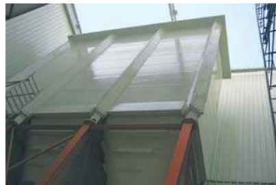
Sudan, Mehl, ● kohäsiv, 3 Zellen á 90 m 3 (Erweiterung auf 7 Zellen vorbereitet)
