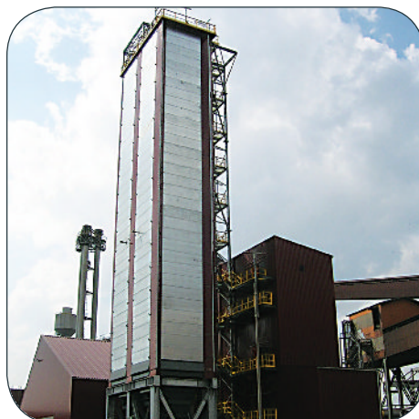
Österreich, Kunststoffpellets, schwerfließend, 2 Zellen à 800 m 3 , Erweiterung auf 5 Zellen vorbereitet
